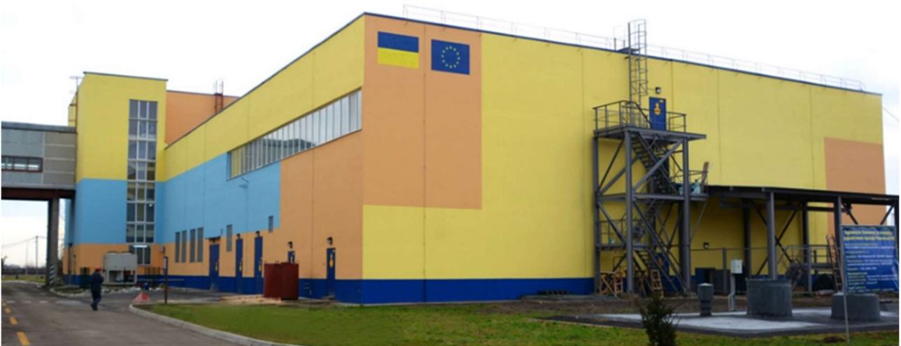
Будівля КПРАВ РАЕС
